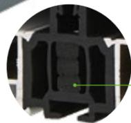
Bouclier thermique PVC haute performance avec traitement spécifique étanchéité à l'air.
